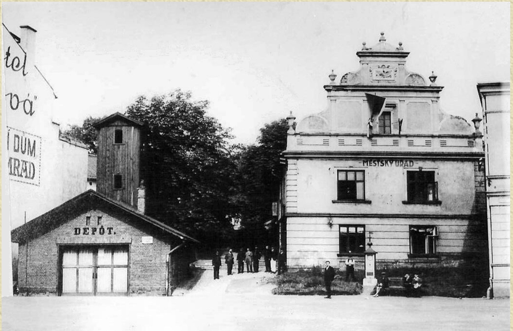
Detail prostoru mezi obchodním domem Chamrad (vlevo) a dívčí obecnou školou (pravý okraj snímku). Nacházela se zde stará požární zbrojnice (sklad - depot) a dům Městského úřadu s pseudorenesančním štítem, pořízeným v roce 1908. Snímek patrně z roku 1927.
