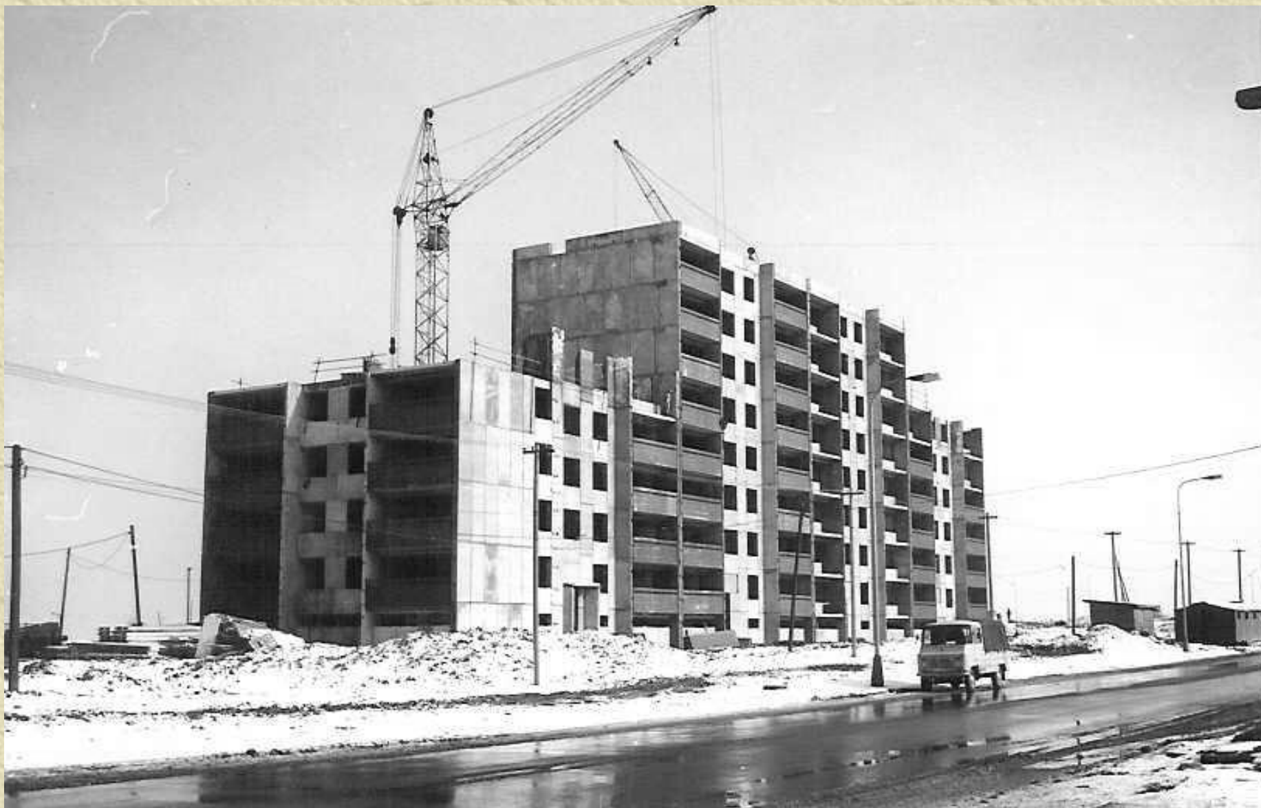
1. blok obytných domů v 3. okrsku nového města ( naproti pozdější nemocnice) stavěný v roce 1976.
