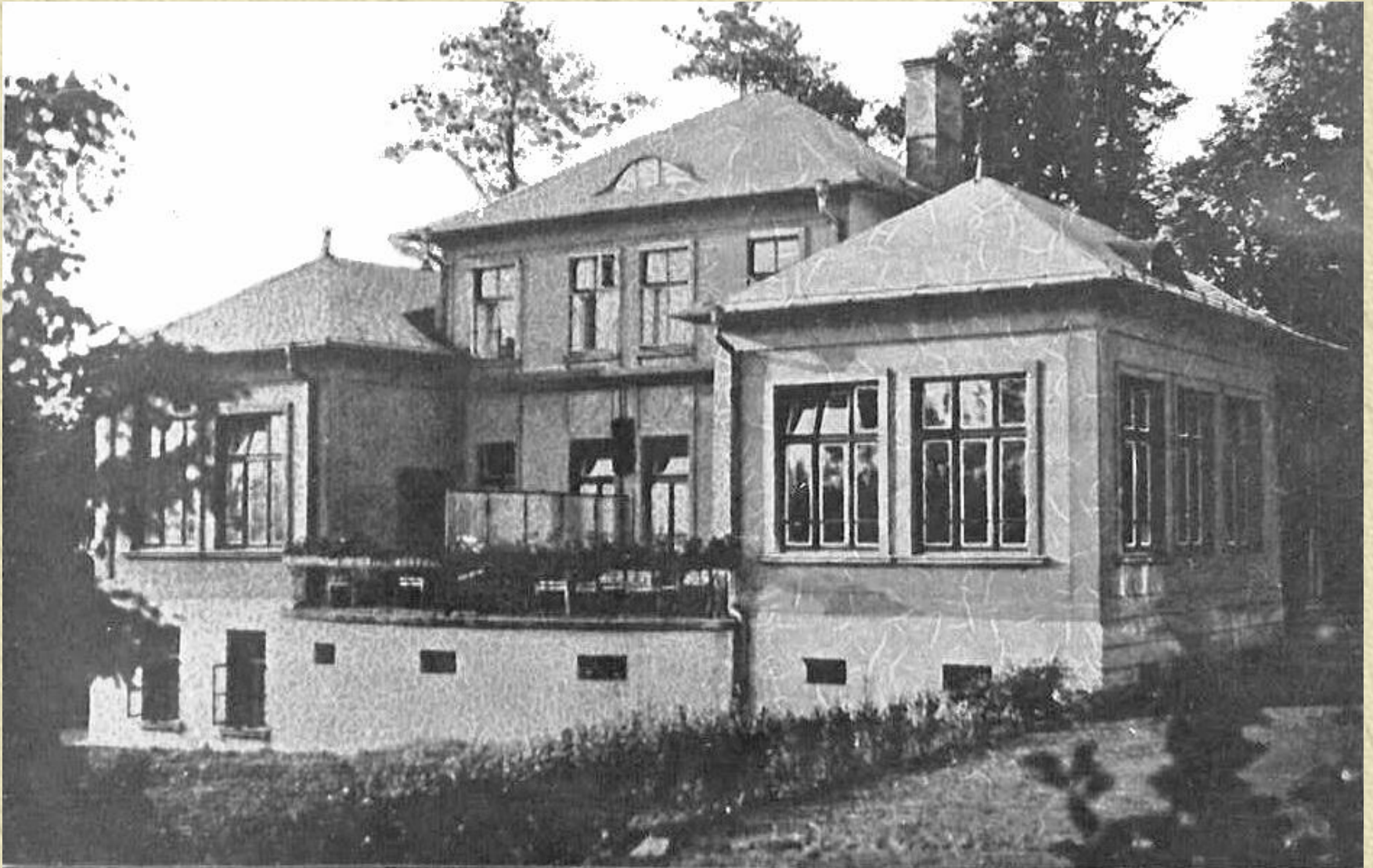
Jeden z pavilonu orlovské nemocnice postavený po 1. světové válce: plicní pavilon z roku 1922.
