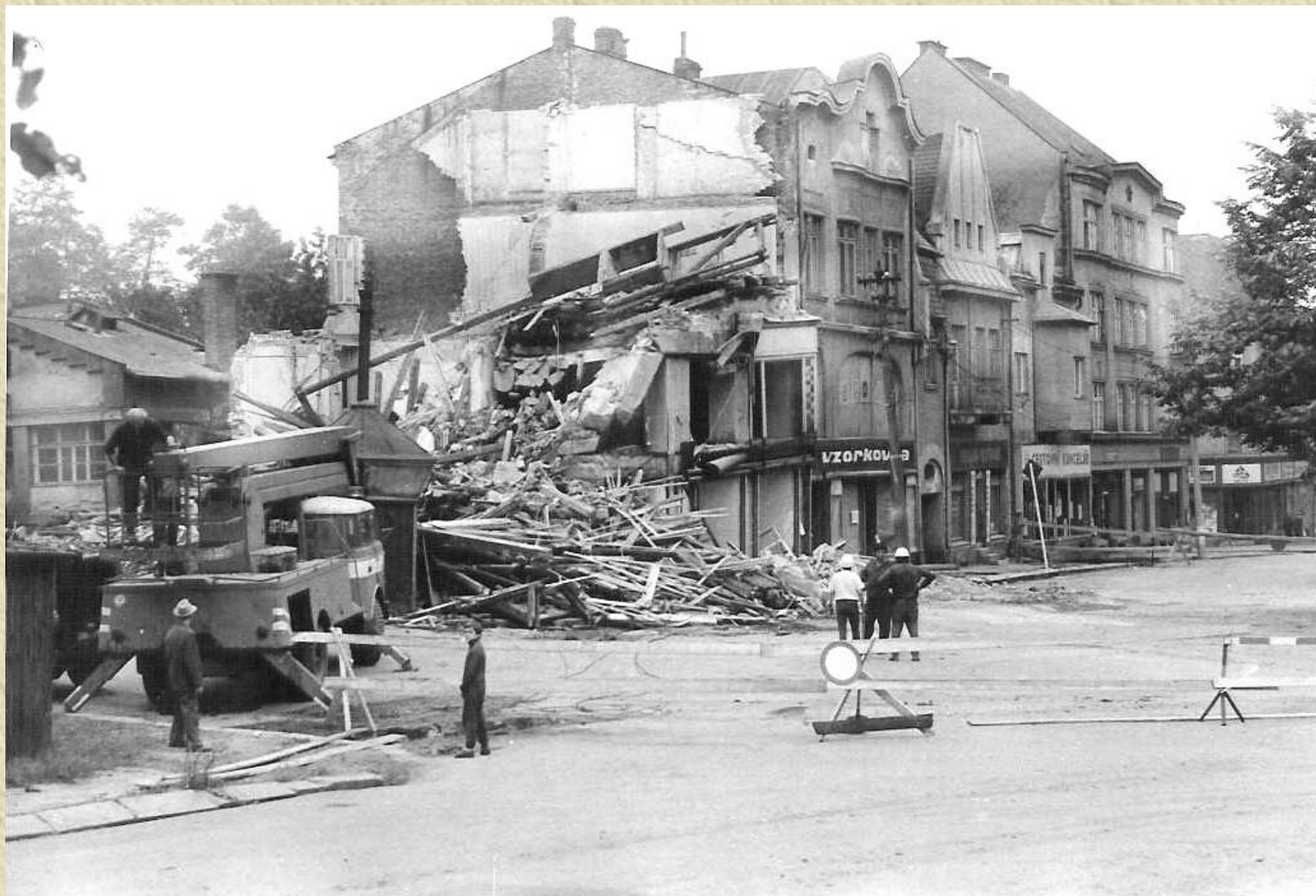
Textilní dům A. Wechsler i s kioskem "věčného ohně" v Orlové při demolici v r. 1981.
