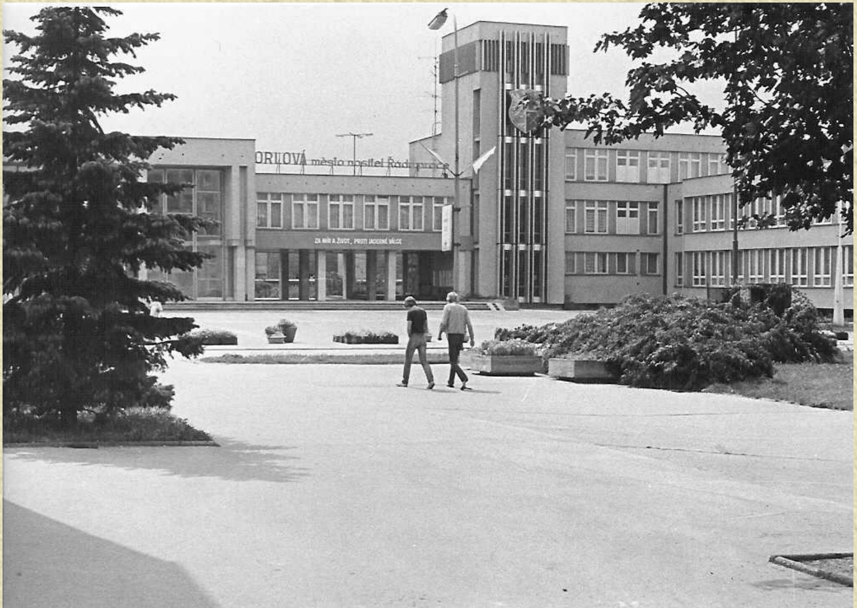
Čelní pohled na administrativní budovu v Orlové (vchod do MěNV) z roku 1983.
